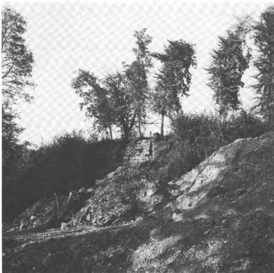
Abb. 5. Kaiseraugst, Liebrüti, Querschnitt der Stadtmauer am Nordrand des Violenbachtals. Ansicht von Süden.
