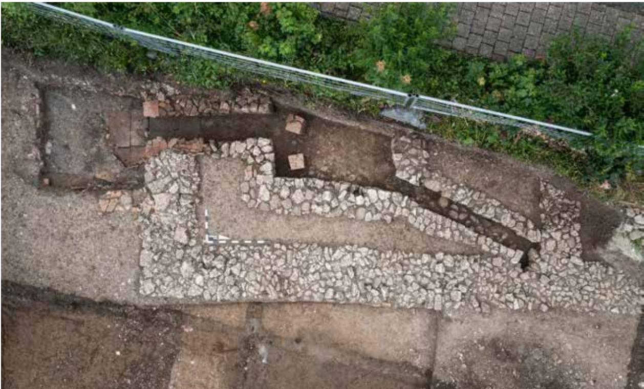
Abb. 4: Kaiseraugst AG, Mühlegasse 25 (Grabung 2022.003). Der Steinbau mit Kanalheizung mit zentraler Verteilkammer (mit zwei erhaltenen pilae) und der dazugehörigen Bedienungsgrube im Süden. Norden ist rechts.
