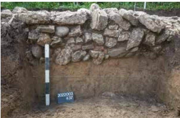
Abb. 5: Kaiseraugst AG, Mühlegasse 25 (Grabung 2022.003). Ansicht der Fundamentschüttung von Mauer MR Pos 326, bestehend aus Muschelkalksteinen, Dolomit, Ziegelfragmenten und Geröll.
