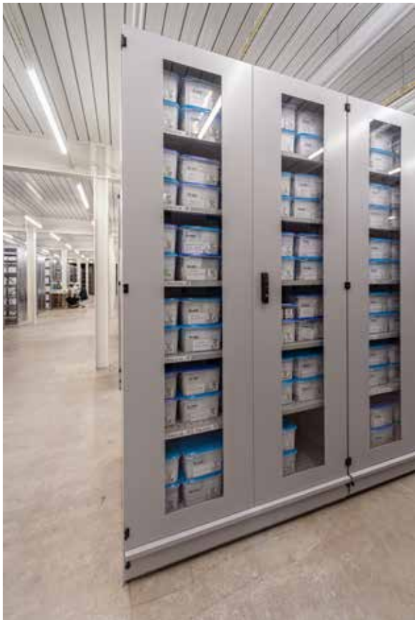
Abb. 14: Sammlungszentrum Augusta Raurica. Die Klimaschränke weisen eine verglaste Türe auf, dank der die Kontrolle der Indikator-kärtchen, die die relative Feuchtigkeit anzeigen, von aussen erfolgen kann, ohne dass der Schrank geöffnet werden muss.
