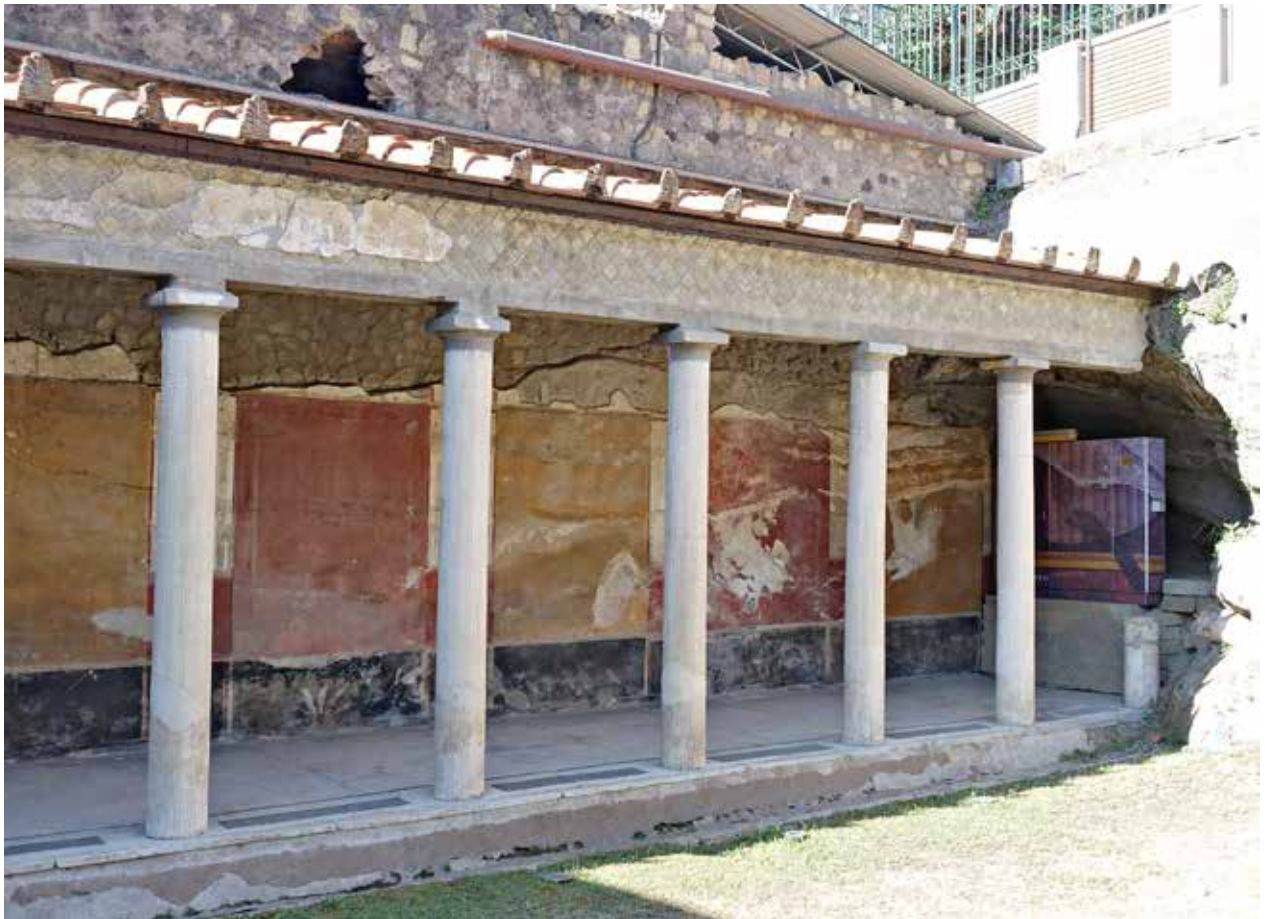
Abb. 58: Oplontis/Torre Annunziata (I). Portikus auf der Nordfassade der sogenannten Villa A.
