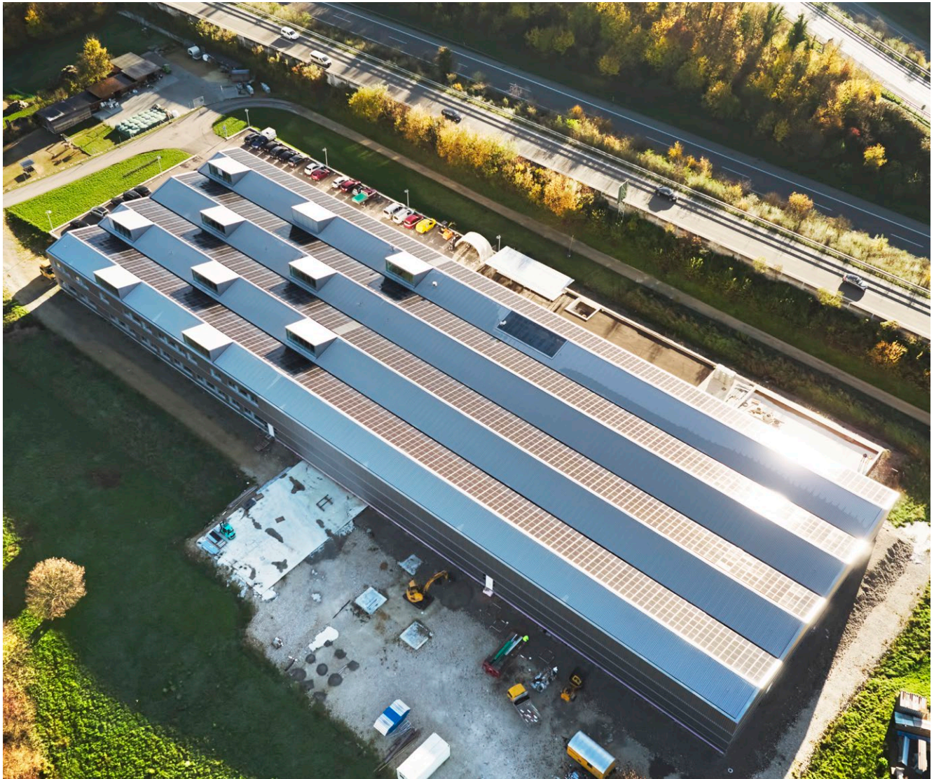
Blick von oben. Es handelt sich um die bisher grösste Photovoltaik-Anlage in der Verwaltung des Kantons Basel-Landschaft. Foto Roman Weyeneth
