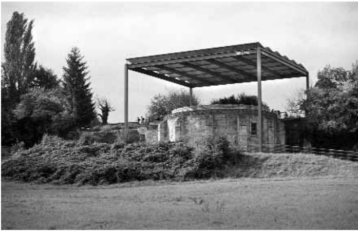
Ein Stahldach schützt die Rotunde der «Curia» vor eindringendem Oberflächenwasser und deutet das Volumen des ursprünglichen Gebäudes an. (Foto Ursi Schild)
