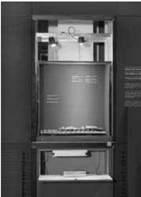
Diese geöffnete Wandvitrine zeigt die Klimaschublade unterhalb der Präsentationsebene und die Beleuchtung von oben, ausserhalb der Vitrine. (Foto Ursi Schild)
