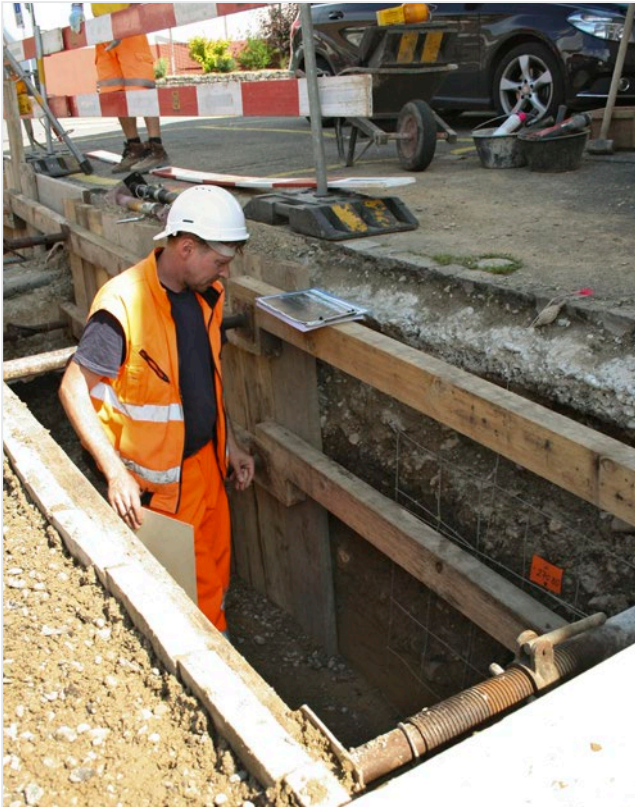
Fredy von Wyl bei der Dokumentation eines Leitungsgabenprofils anlässlich der Baubegleitung Augst-Landstrasse 2016.055. Foto Adrian Jost
